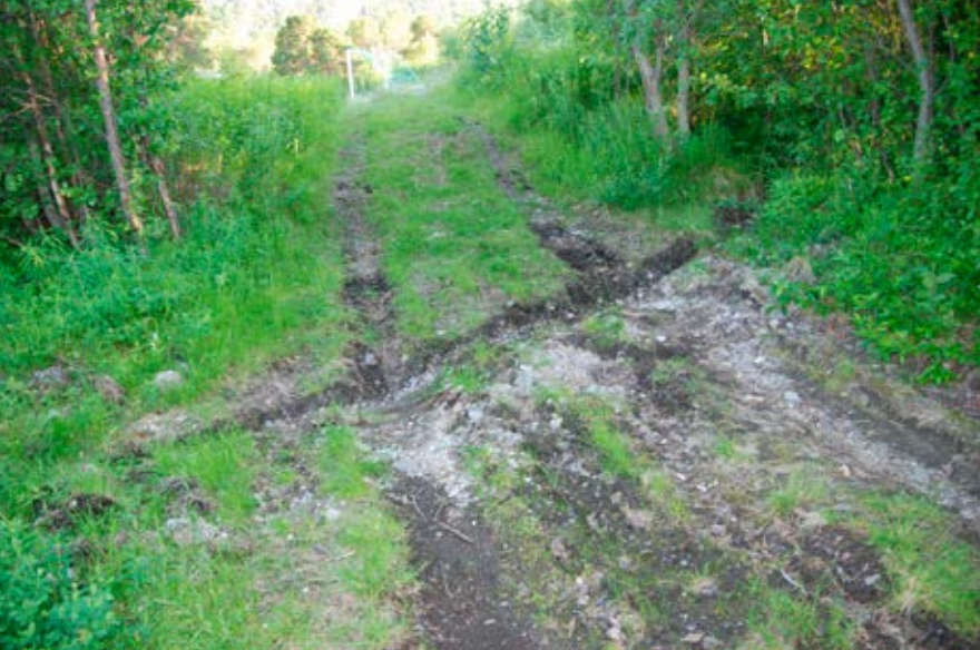
Ulovlig grøftegraving ved Amtmannsnes 2B.
