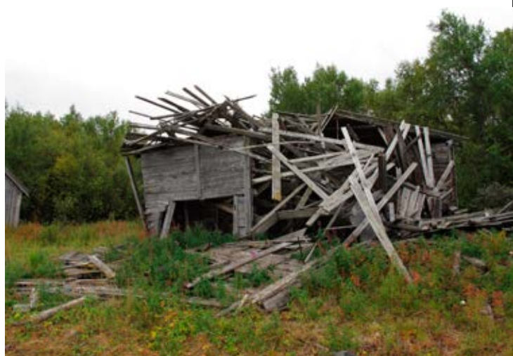
Et av de gamle naustene i Hjemmeluft.
