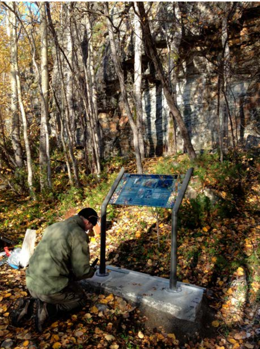
Informasjonsskiltet monteres i Transfarelv.
