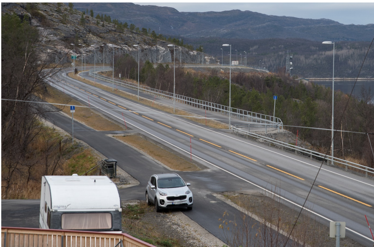
E6 på vestsiden av Hjemmeluft etter utbygging, foto: Arve Kjersheim.
