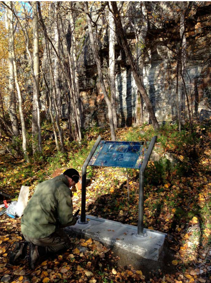
Informasjonsskiltet monteres i Transfarelv.
