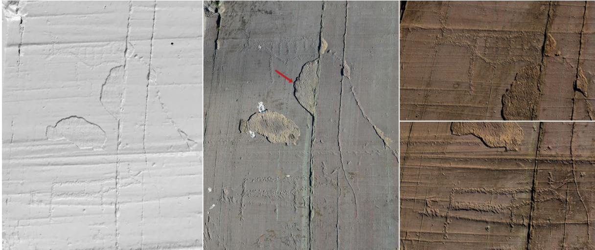
Figur 58. Denne typen avskalling/eksfoliasjon blir ofte trukket frem som ekstra bekymringsverdig. Skanningen til venstre er fra 2002, og på det midterste bildet fra 2015, kan man ved å sammenligne se at avskallingen har blitt litt større ved den røde pilen. Bildene helt til høyre (2018) har bare delvis med avskallingene, og er eksempler på at det er figurene som har vært motivet for fotograferingen, og ikke skadene i berget. Foto: K. Tansem, VAM, skanning: Metimur AB.
