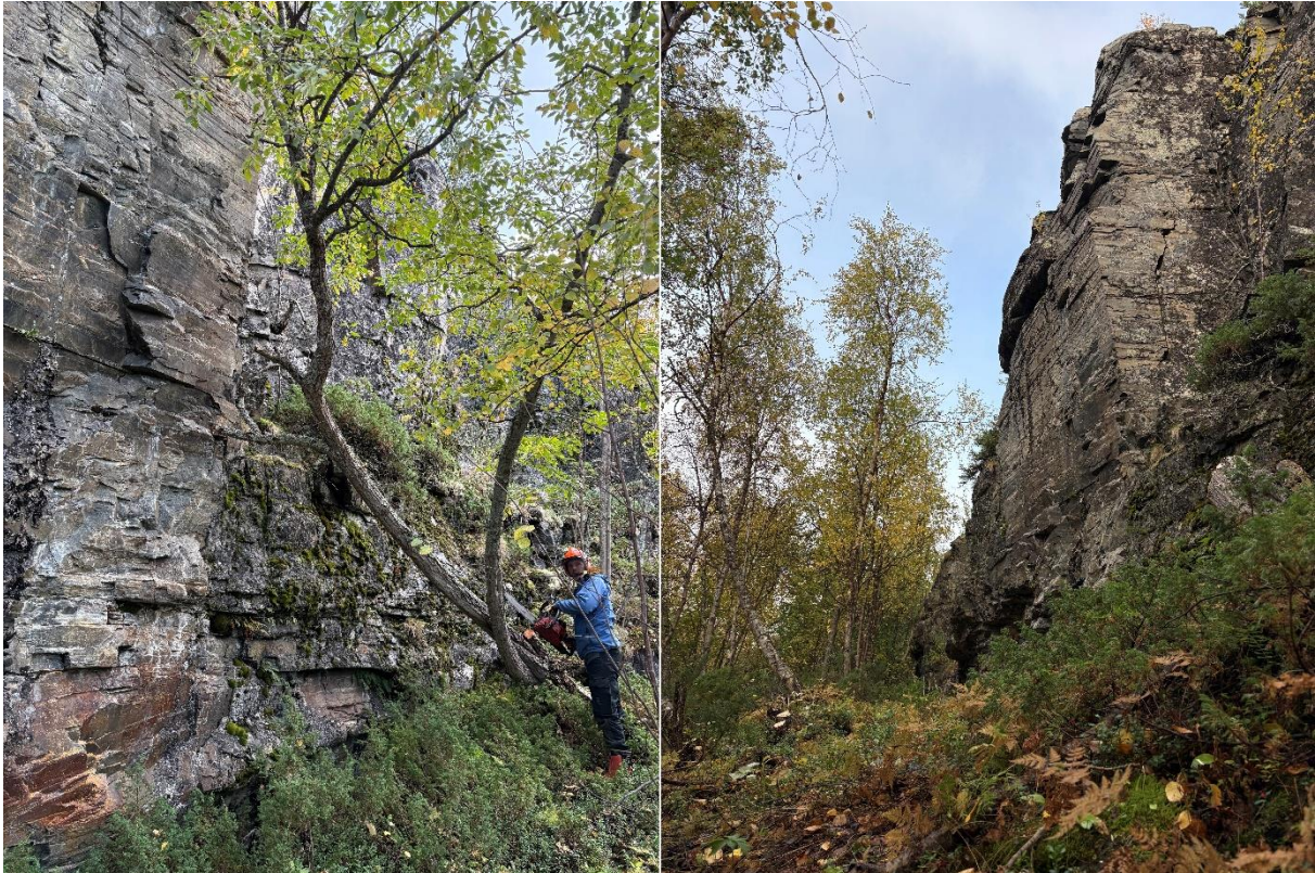
Figur 3: Et tre truet feltet Transforelv 4 (Askeladden ID: 101462) og måtte fjernes. Det ble samtidig ryddet andre trær som sto i fare for å falle mot bergflaten. Foto: Eirik H. Røe og R. Normann.
