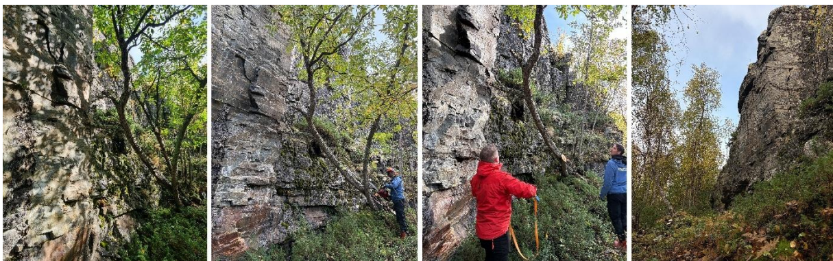
Figur 8. Før, under og etter nedtaking av trær ved Transfarelv 4. Foto: R. Normann og E. H. Røe, VAM
