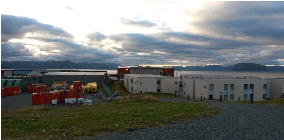
Foto: Fra Meridianstøtta mot Seilandstuva. ISPS- terminalen til venstre, hybelhus til høyre med gammel helikopterhangar i bakgrunn 2016. GJV
